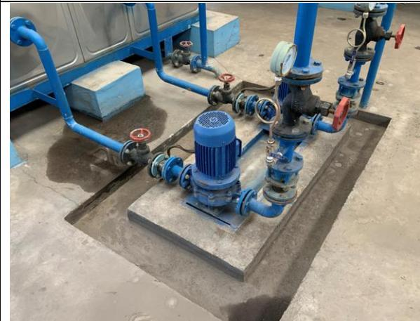
水泵减震基础
