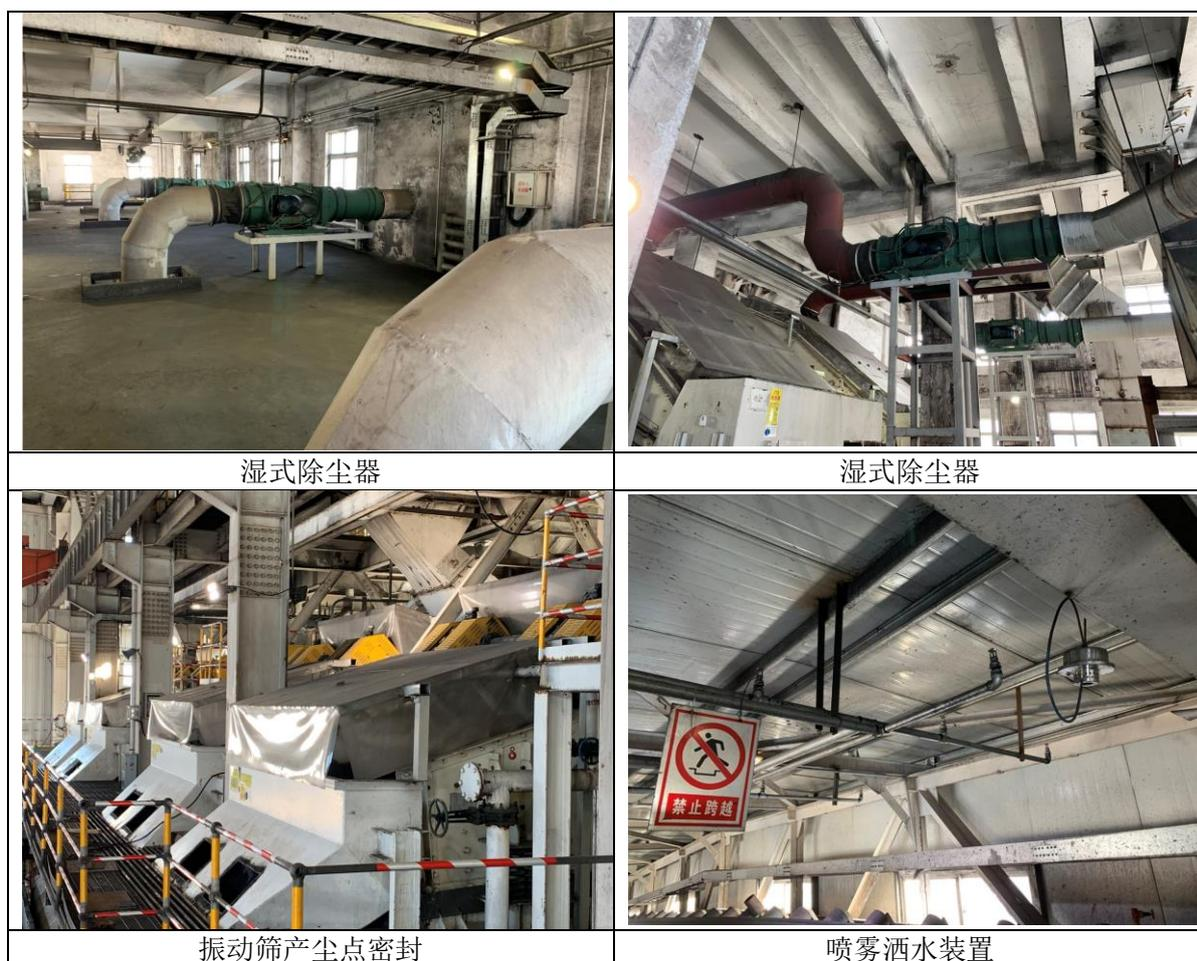
图 8.3-2 筛分破碎车间除尘设备图
